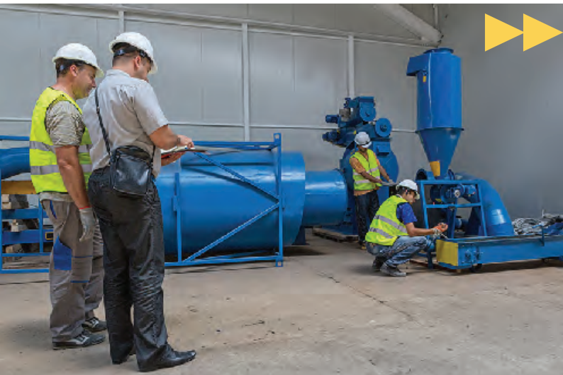
Montiranje opreme u fabrici Termovent u Medveđi.
